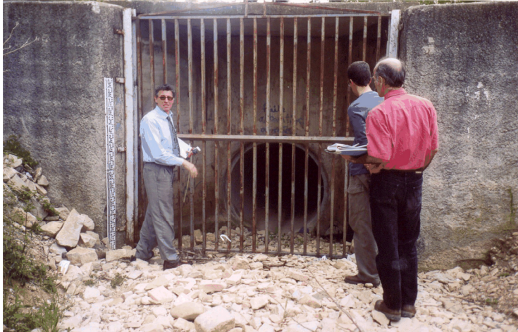
Figure 7. Entrée du collecteur enterré en amont immédiat de la zone à habitat dense
