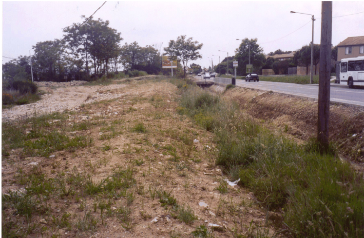
Figure 6. Talweg à ciel ouvert en aval du barrage écrêteur de crue, dans une zone pavillonnaire à urbanisation peu dense
