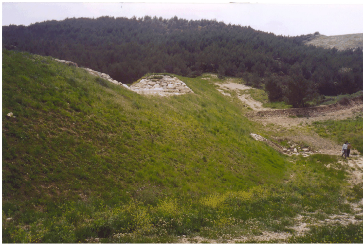
Figure 3. Barrage écrêteur de crue. Photo prise à l'intérieur de la cuvette
