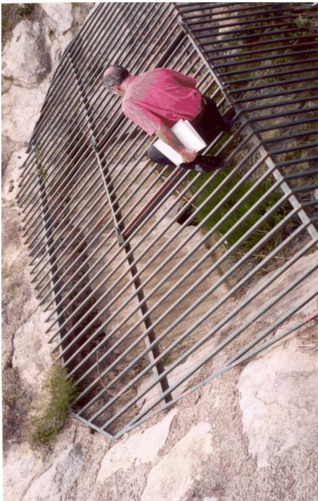
Figure 4 : Entrée du pertuis du barrage écrêteur de cure - l'entrée du pertuis est protégée par une grille de protection
