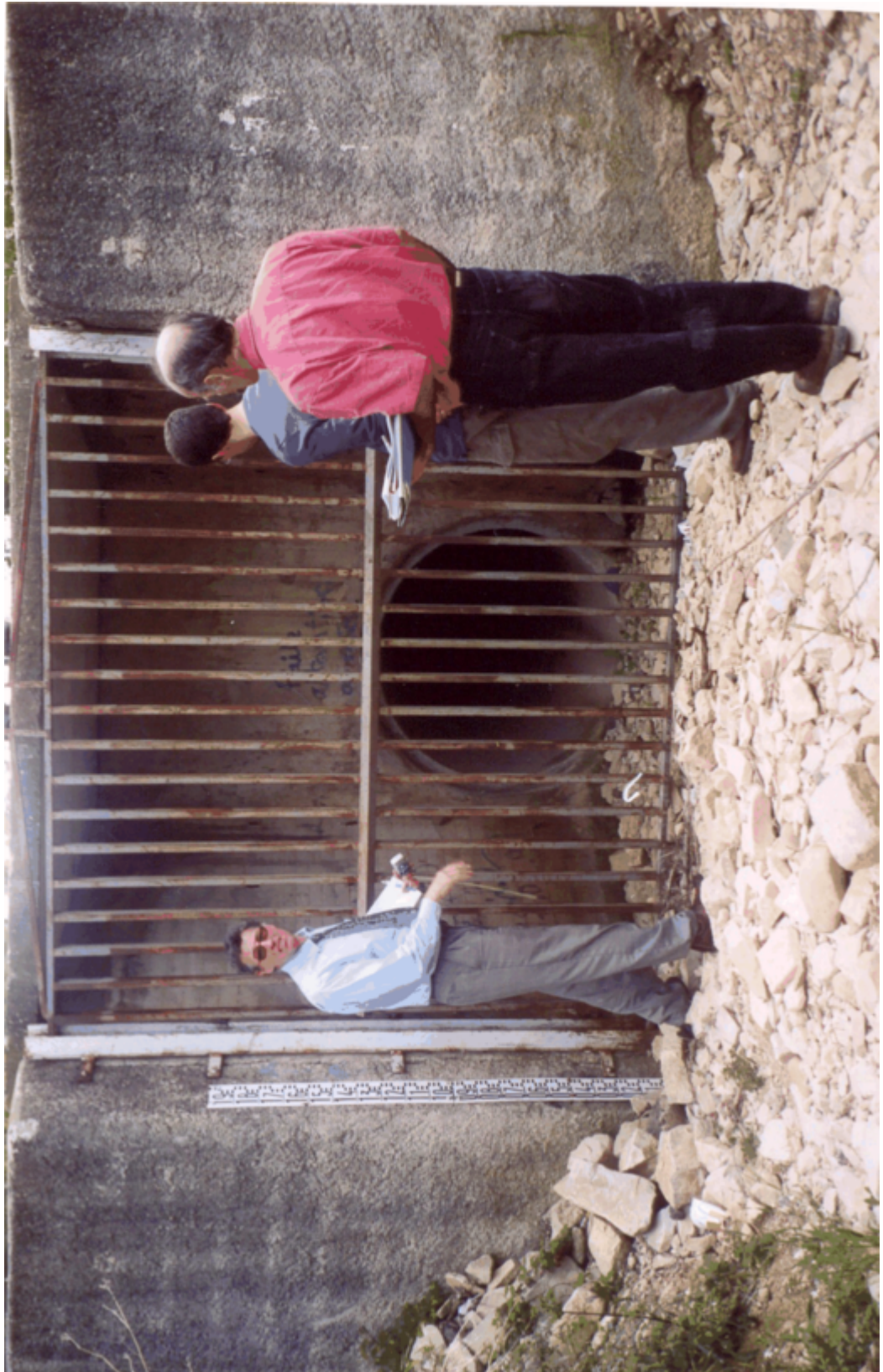
Figure 7 : Entrée du collecteur enterré en amont immédiat de la zone à habitat dense
