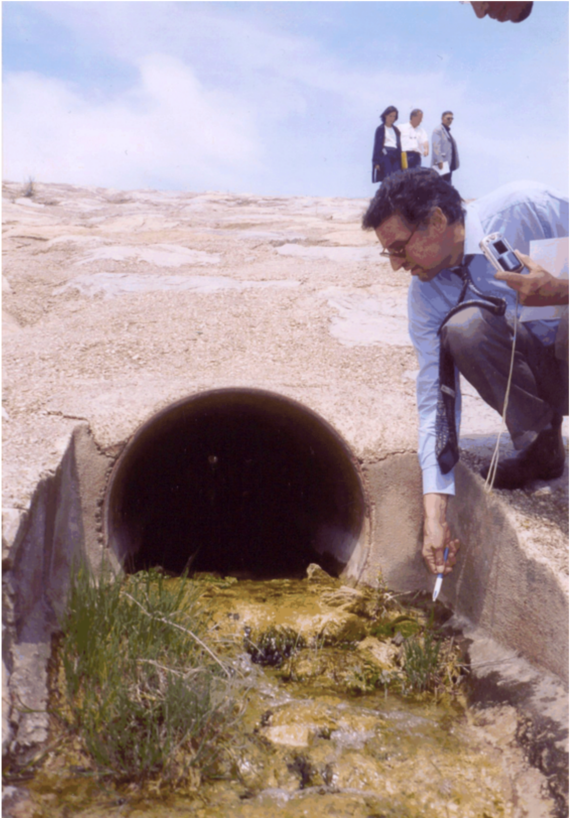
Figure 5 : Sortie du pertuis du barrage écrêteur de crue - vue depuis l'aval
